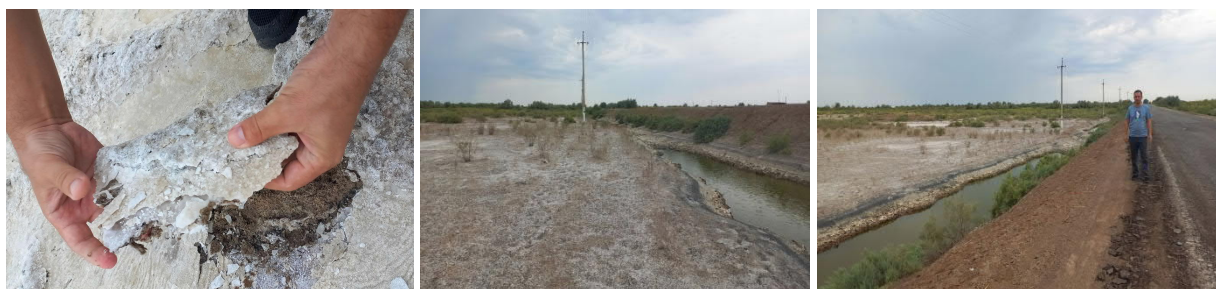
1-rasm. Sho'rlangan gruntli hududlardan o'tuvchi avtomobil yo'llarida yuzaga kelgan deformatsiyalar
