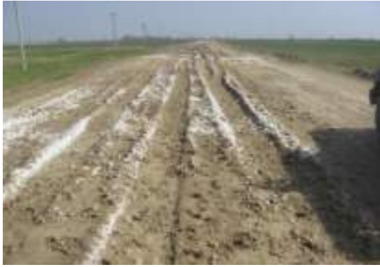
Рис. 4.9. Появление солей на поверхности земляного полотна
